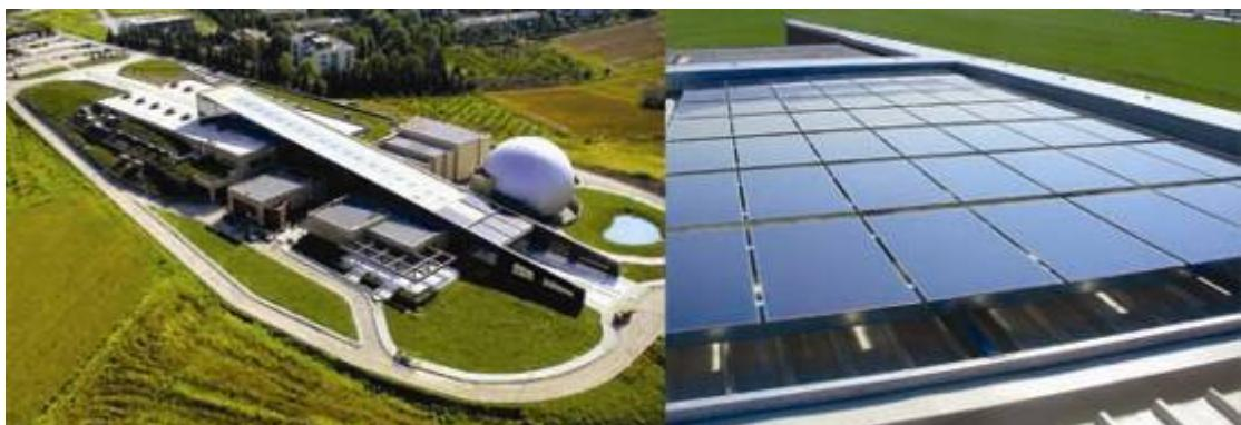
Ενσωμάτωση άμορφων φωτοβολταϊκών στο Τεχνολογικό Μουσείο Θεσσαλονίκης
