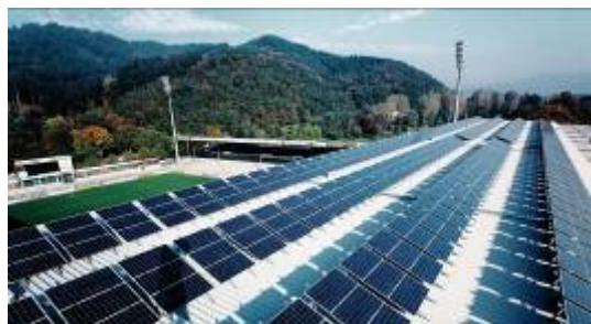
Ενσωμάτωση φωτοβολταϊκών σε γήπεδο ποδοσφαίρου
