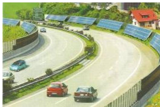
Εφαρμογή φωτοβολταϊκών σε ρόλο ηχοφράγματος σε αυτοκινητοδρόμους
