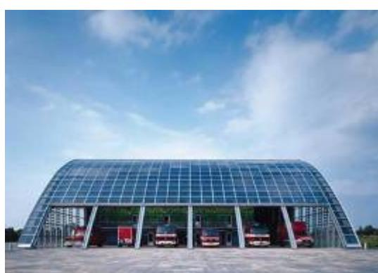
Ενσωμάτωση φωτοβολταϊκών σε πυροσβεστικό σταθμό
